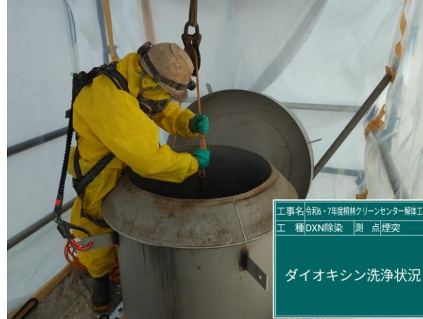
除染（洗浄作業）
