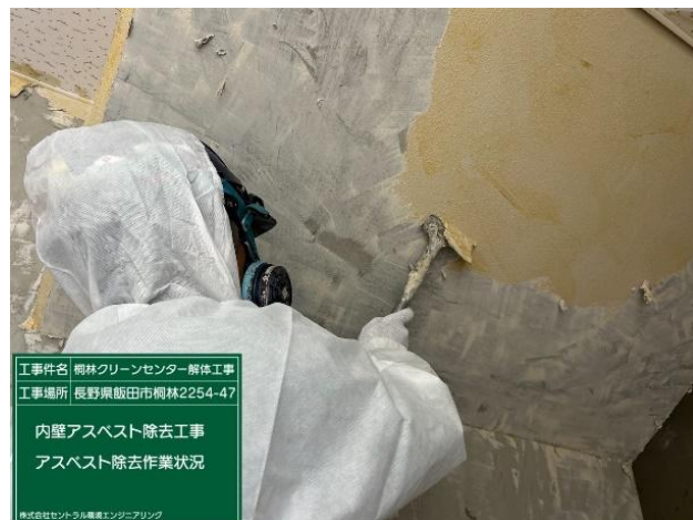
除去作業（湿潤化後）
