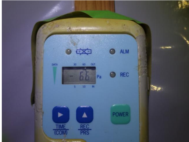
負圧計による密閉養生確認
