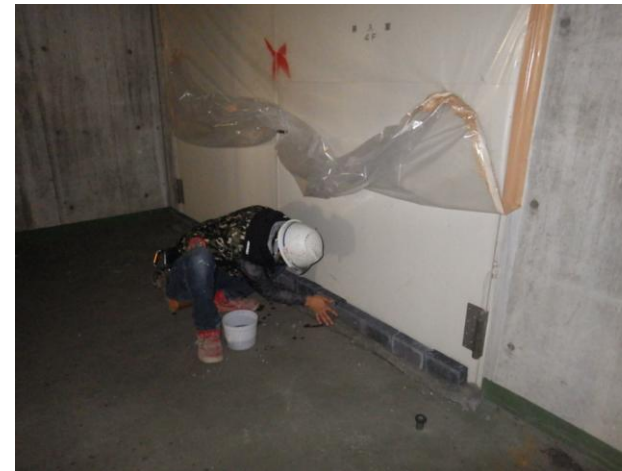
防液堤の設置確認
